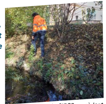
Les techniciens du SIRCC procèdent régulièrement à la surveillance de l'état des berges et des digues.
