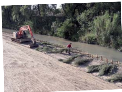
Des pieux plantés, entre lesquels sont tressées des branches de saule, forment une protection de pied de berge appelée "fascine". (Travaux d'aménagement du Coulon à Cavaillon, 2016).
