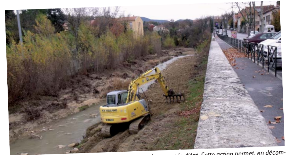
Scarification d'un banc de galets par le SIRCC dans la traversée d'Apt. Cette action permet, en décompactant les matériaux par griffage, et en détruisant les systèmes racinaires, de faciliter la remobilisation du banc lors des prochaines crues sans provoquer de déséquilibre sédimentaire.
